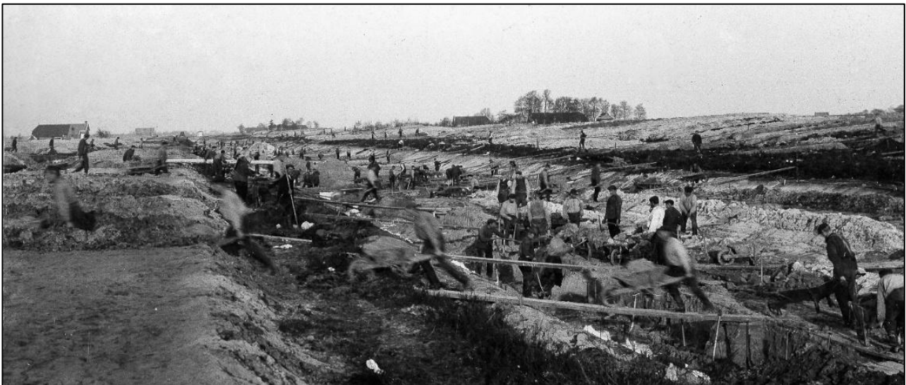
Afb. 3: Aanleg van het Vereenigd of B.L. Tijdenskanaal 1908-1912. Het graven is grotendeels met de hand gedaan. Wanneer het gegraven deel bevaarbaar is, wordt het kanaal door mechanisch uitbaggeren op diepte gebracht. Bij de aanleg van de aansluitende Ruiten-Aa en Mussel-Aa kanalen is gedeeltelijk ook machinaal gegraven. Foto: Tonnies Post; Archief Waterschap Hunze en Aa's.
