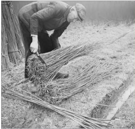
Het opbossen van wilgentenen (links). Rijshout verwerkt in zinkstukken voor de Afsluitdijk (rechts)
