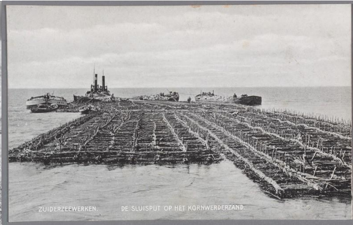
Het opbossen van wilgentenen (links). Rijshout verwerkt in zinkstukken voor de Afsluitdijk (rechts)
